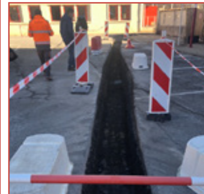
Tranchée des canalisations du réseau de chaleur
