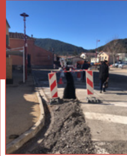
Tranchée des canalisations du réseau de chaleur
