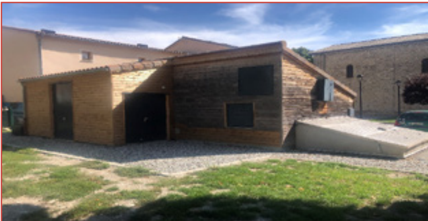
Chaufferie après extension
