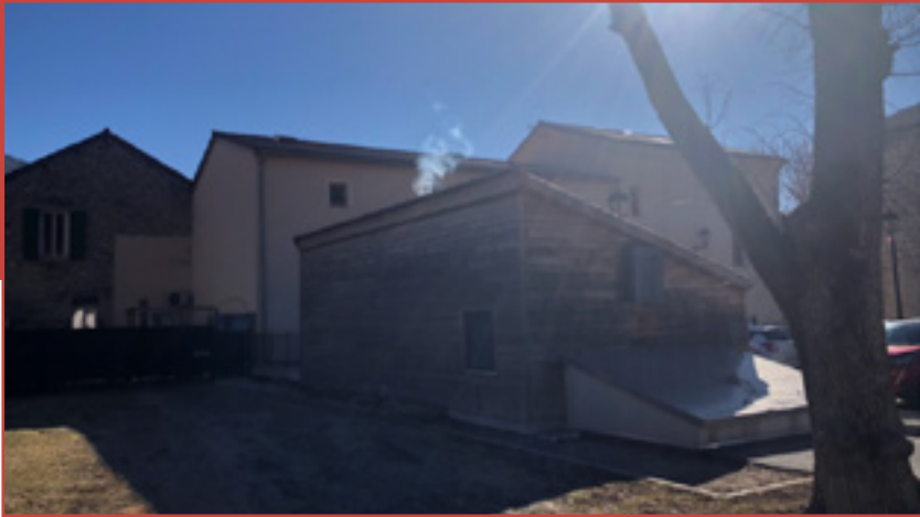
Chaufferie avant extension
