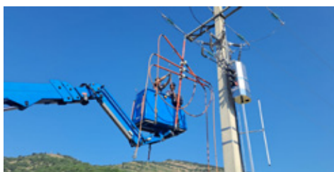
Pose d'un troisième poste de télécommande "Auguste" par les équipes d'Enedis Alpes du Sud.
